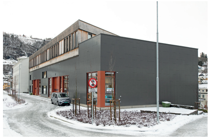
Nybyggets hjørne mot sørvest.
